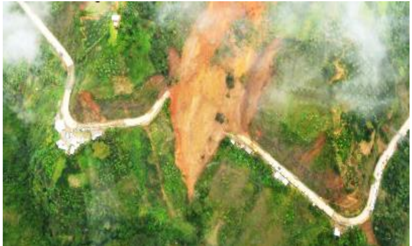
Figura 28: Deslizamiento en ruta Turbo – Medellín. Fuente: www.eluniversal.co 28/sept 2010
